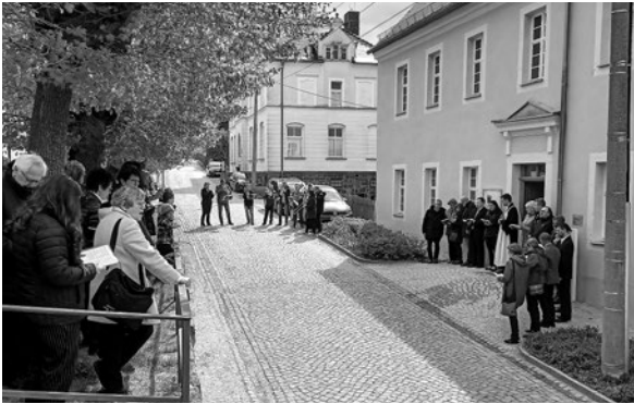
Altes Gemäuer total saniert: Die Kirchschule.
