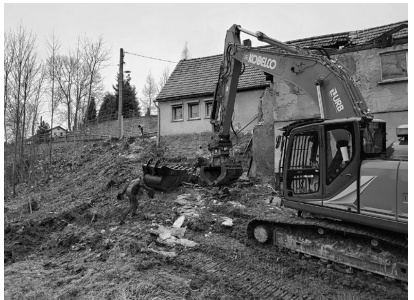
Vom Haus Oberlausitzer Straße 30 dürfte bei Erscheinen dieser Zeitung nicht mehr viel übrig sein. Mehr zu Bauvorhaben auf Seite 5.
