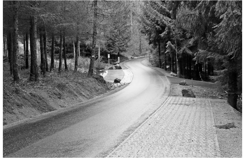
Eines der bisher größten Vorhaben der Teilnehmergemeinschaft war der Ausbau der Zufahrt zum Czorneboh im Jahre 2015.
