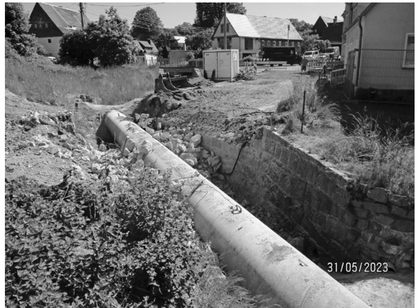
31. Mai 2023. Die Brücke ist zurückgebaut. Unverzüglich ist der Neubau begonnen worden.
