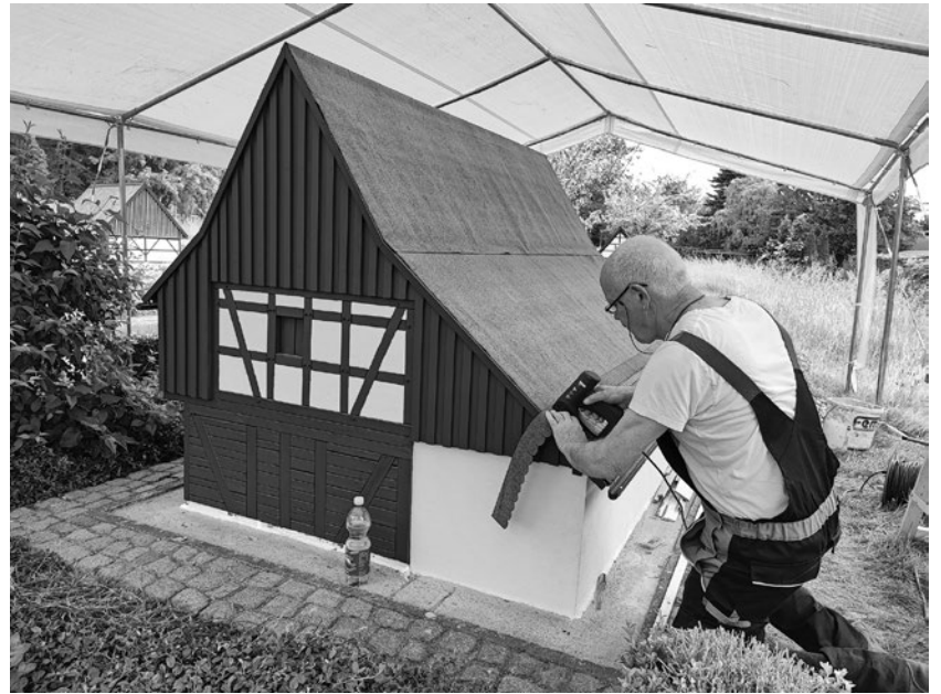
Bei der Reparatur der Umgebendehäuschen ist Sachkenntnis, Geschick aber auch Leidenschaft gefragt. Volkmar Fröde hat alles!
