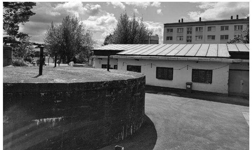
Die Trinkwasserzisterne am Bauhof ist jetzt Wasserreservoir.
