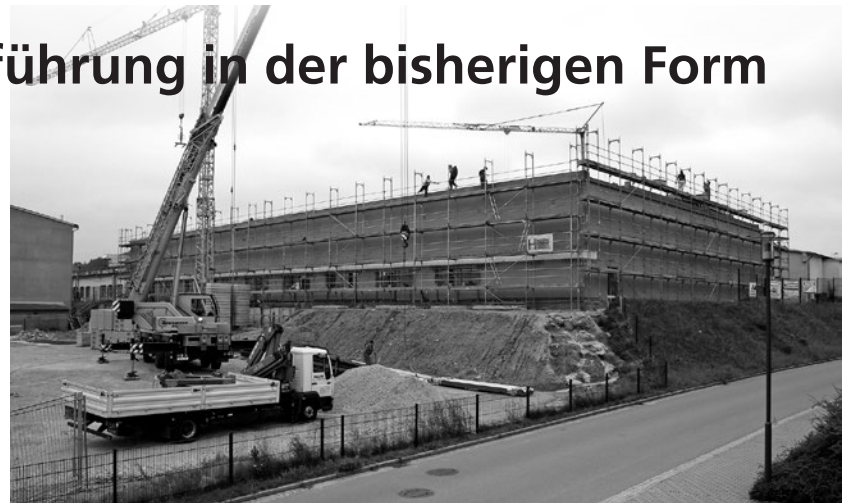
Höhepunkt des kontinuierlichen Ausbaus des Standortes war der Hallenneubau durch die Fa. Küpper im Jahre 2008.
