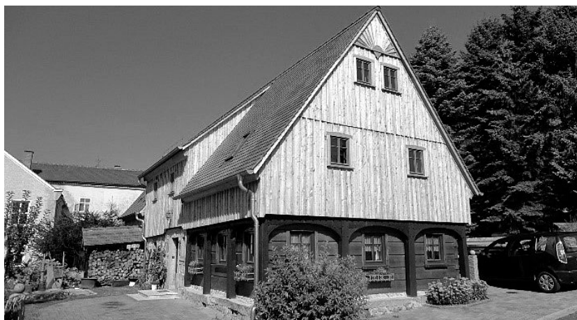
Hauptstraße 195 nach der Sanierung 2016. Hohe Förderquote mit 45 Prozent, Fördersumme knapp 30.000 €.
