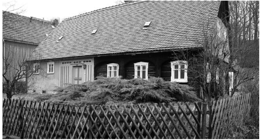
Hauptstraße 123 in Mittelcunewalde. Am sehr schönen kleinen Umgebendehaus sind umfangreiche Sanierungsarbeiten erforderlich.
