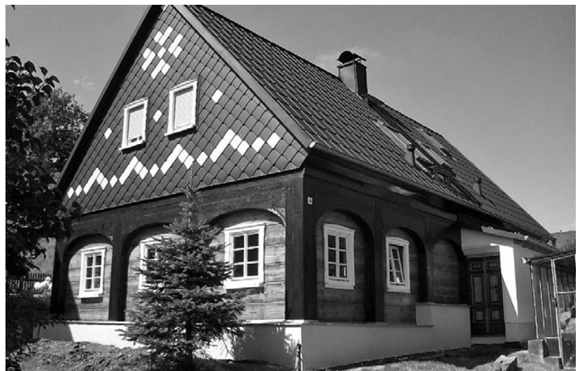
Schmiedegasse 4 nach der Sanierung von Dach, Dachstuhl, Fassade mit Dämmung, Fenster, Außentüren, Trockenlegung. Förderhöhe 40 Prozent, in Summe knapp 40.000 €. Fertigstellung August 2013.
