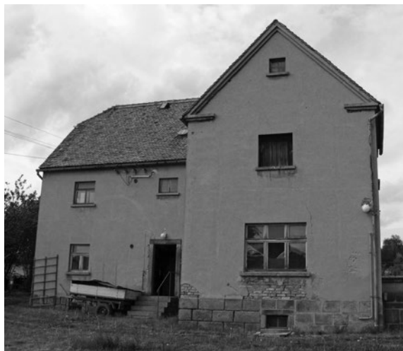
Das Hauptgebäude der ehemaligen Gärtnerei Großer in Obercunewalde vor der Sanierung.
