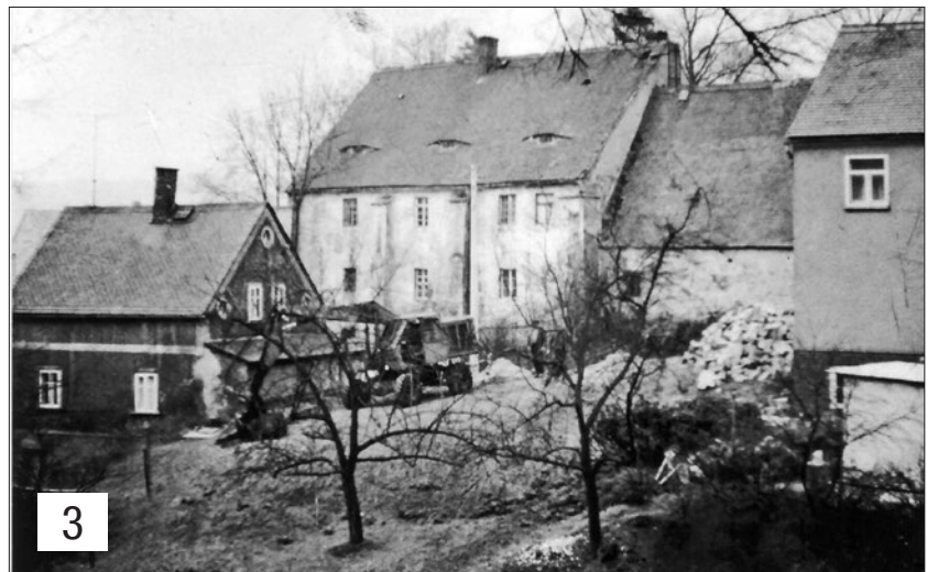
Offensichtlich wird an dem kleinen Haus links gebaut. Wo wir uns hier befinden, verrät uns der Blick auf das imposante Gebäude in Bildmitte, das in den letzten Jahren denkmalgerecht saniert worden ist.
