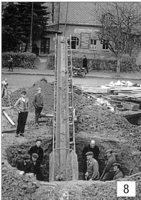
Hier wird ein Erdloch für eine Klärgrube ausgehoben. Viel Handarbeit, wenigstens ein Förderband stand zur Verfügung. Wo sind wir?
