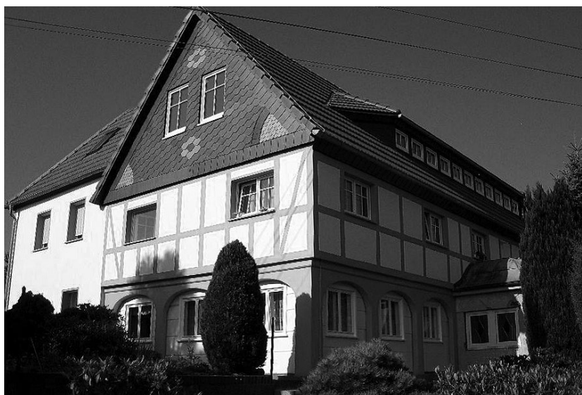
Hoppebergweg 4 nach der Erneuerung von Dachstuhl, Eindeckung, Fassade und Fenster im August 2012. Förderquote 40 Prozent, Fördersumme 37.400 €.
