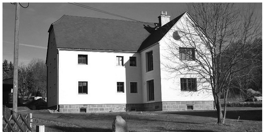
Schanzenweg 7 nach der Komplettsanierung. Fördersumme rund 44.000 €, das sind 20 Prozent der Gesamtkosten. Fertiggestellt im März 2015.
