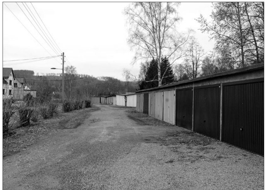
Garagenstandort Matschenstraße. Bis Ostern sollen hier Reparaturarbeiten an der Zuwegung erfolgen.
