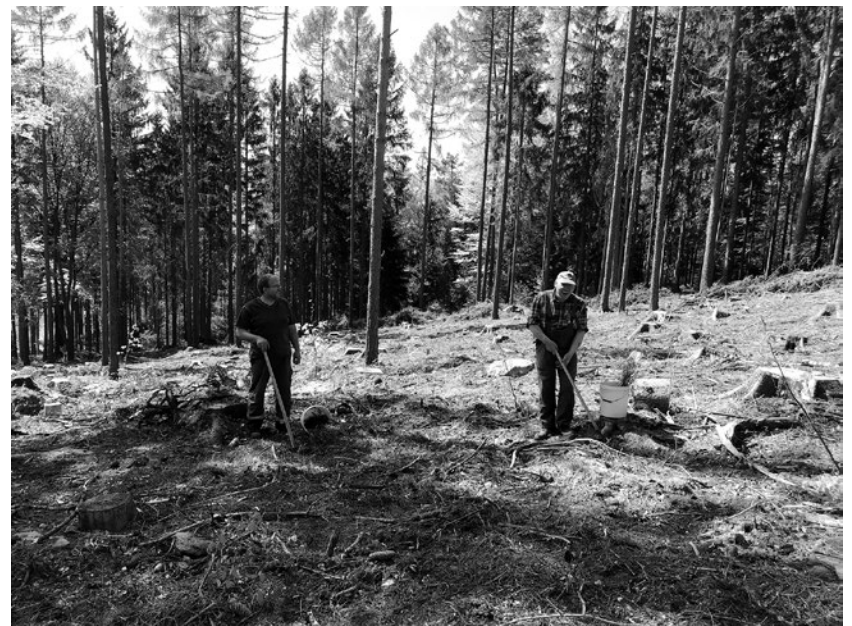
Die beauftragte Firma Lindner bei den Pflanzarbeiten auf kommunalen Waldflächen. Alle hoffen auf Regen.
