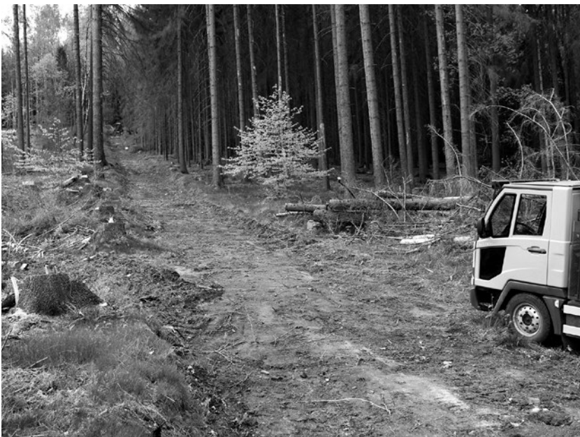
Mit ersten Wegebaumaßnahmen hat der Gemeindebauhof an der Rodelbahn Richtung Zieglertal begonnen.
