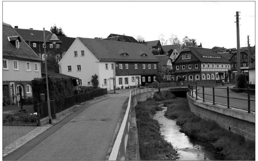
Voraussichtlich am 22. April werden die direkten Bauarbeiten an der Stützmauer zum Erlenweg beginnen.
