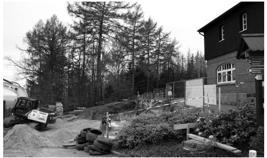
Blick auf die Baustelle an der Bieleboh-Baude. Hier wird der Festsaal in das hängige Gelände gebaut.
