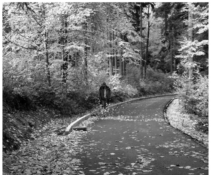
Hier wurde nicht etwa der Wald gefegt“ Beim Bau der Zufahrt zum Czorneboh im Herbst 2015 musste vor der Asphaltierung der Deckschicht permanent herabfallendes Laub beseitigt werden.
