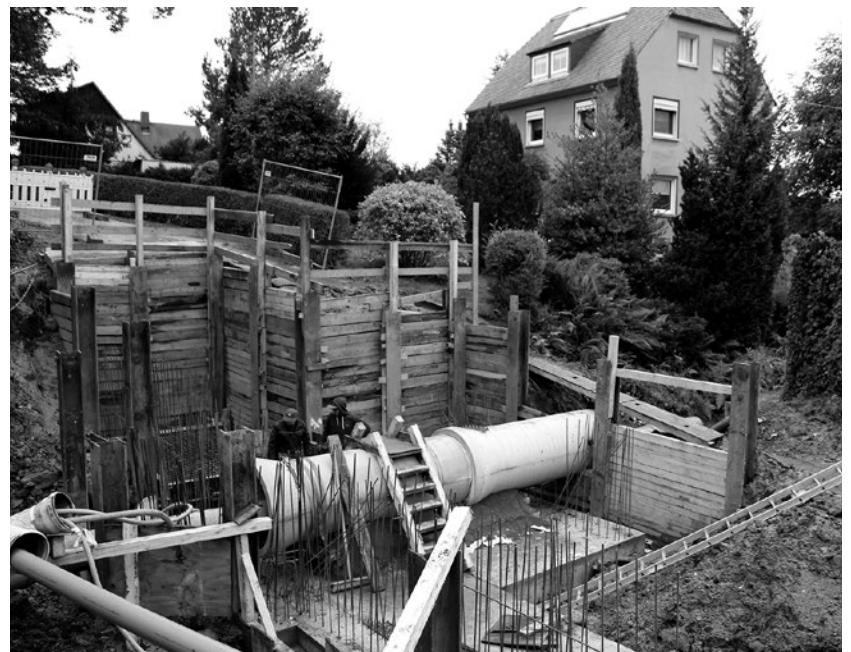
Die Baugrube am Löschteich im Zieglertal. Was sich wie eine kleine Aufgabe anhört, ist doch mit erheblichem Aufwand verbunden.
