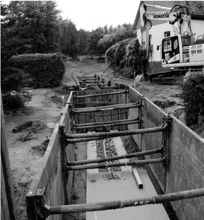
Blick in die Baugrube des neuen Kanals am Schlosserteich. Der Damm zum Teich im Hintergrund ist geöffnet worden. Mehr dazu und weiteren Baustellen auf Seite 9.
