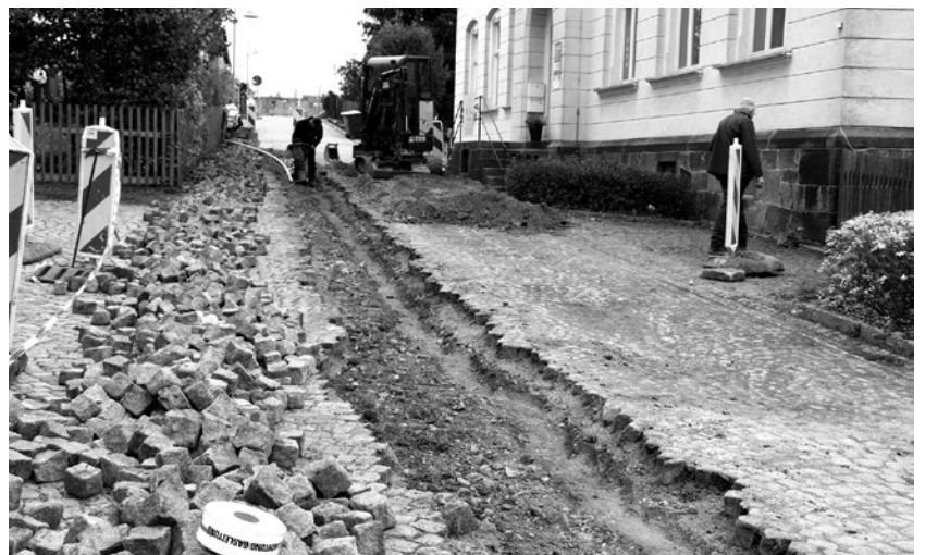
Blick in den Kirchweg, inzwischen ist die Straßendecke wieder geschlossen.
