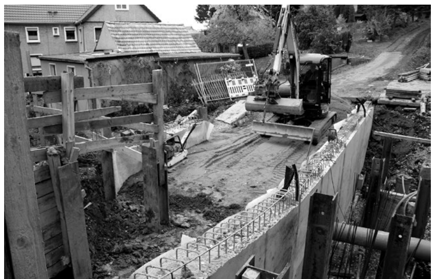
Im Zieglertal ist der Straßenbau im Gange, die Mauern stehen.
