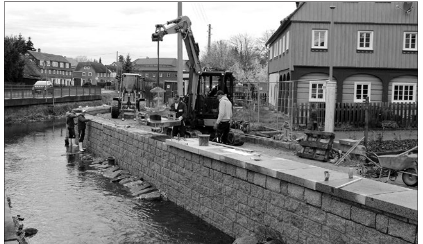
Am Erlenweg geht's voran. Hier ist die Firma Neitsch bereits dabei, die Mauer- kappe herzustellen.
