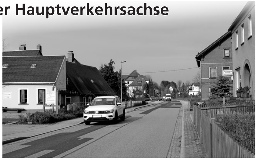
Auf etwa 30 m Länge wird hier im Bereich Fahrrad-Vogt/Keramik-Trillenberg der Straßenbelag erneuert. ACHTUNG VOLLSPERRUNG!
