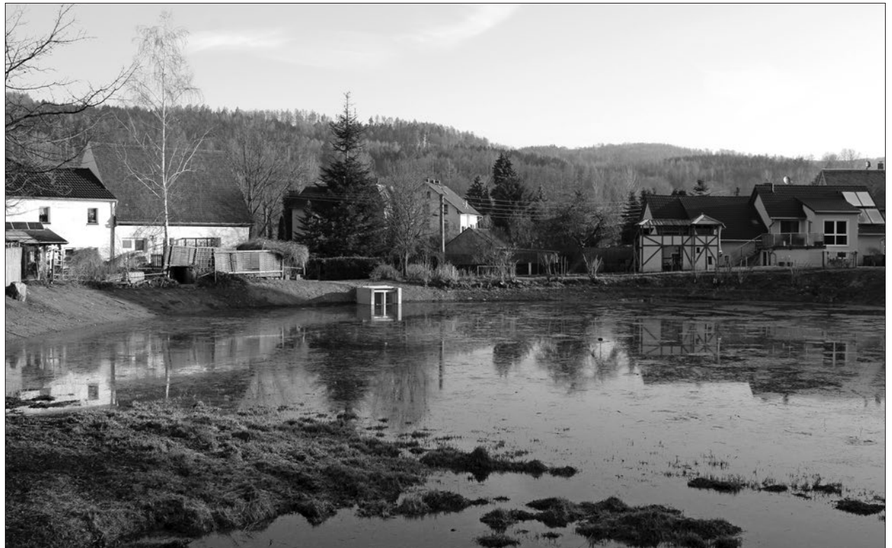
Die Probleme mit dem Überlauf sind behoben, langsam füllt sich der Schlosserteich.
