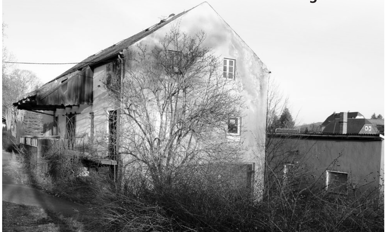
Die alte BHG (Bäuerliche Handelsgenossenschaft) unweit des Bahnhofes Obercunewalde hat die besten Zeiten hinter sich.
