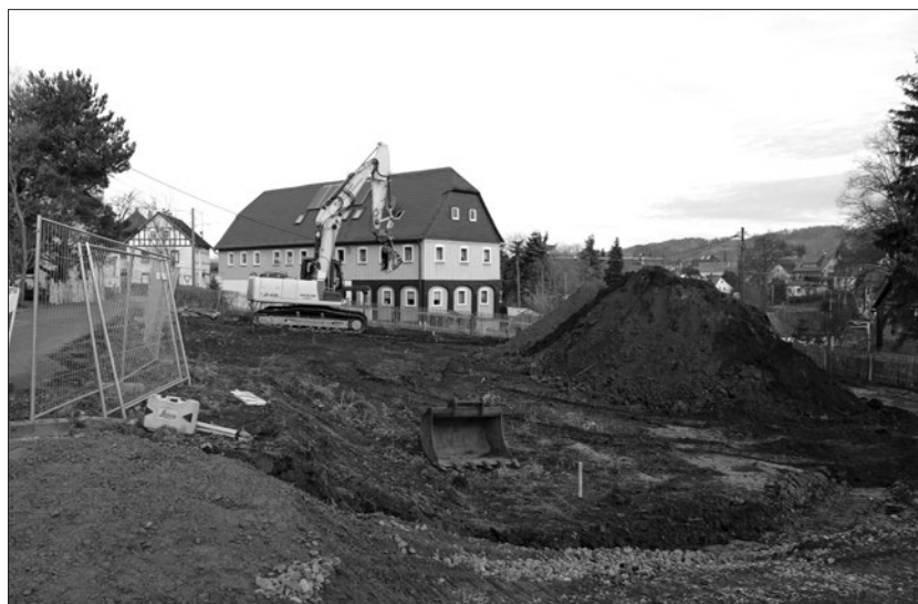
Wo einst das Bahnhofsrestaurant (Wolf's) stand, haben Bauarbeiten zur Errichtung eines Wohngebäudes begonnen. Mehr zum Thema „Brachen“ auf Seite 9. Mehr zum Vorhaben am Bahndamm in der nächsten CBZ.
