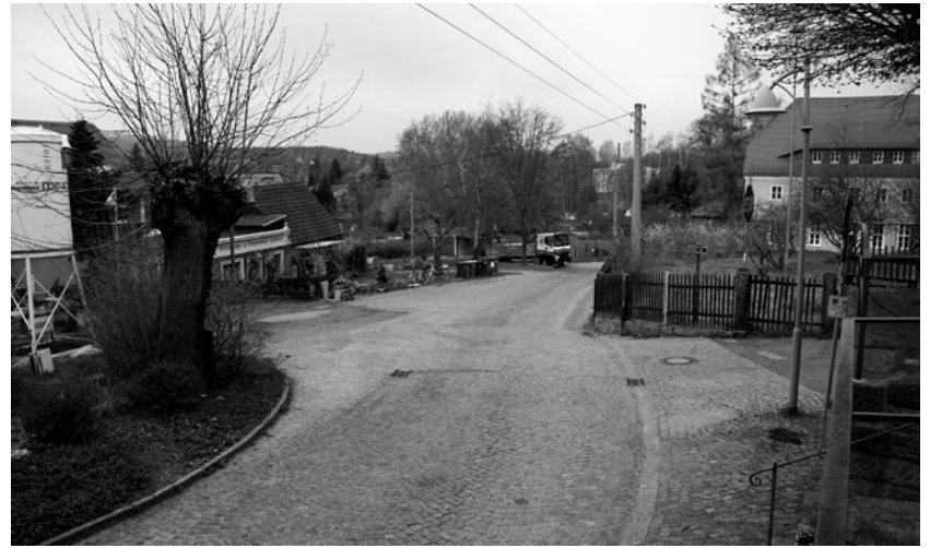
Blick auf den Kirchweg – hier wird nach Pfingsten die Baustelle eröffnet.
