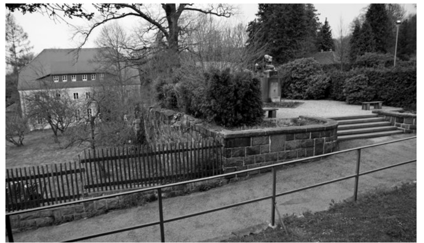
Die Arbeiten an der Stützmauer zum Denkmal an der Straße zum Friedhof stehen kurz vor dem Beginn. Sobald die ökologische Baubegleitung grünes Licht gibt, startet die Mauersanierung. Mehr zum Gesamtvorhaben Kirchweg auf Seite 7.
