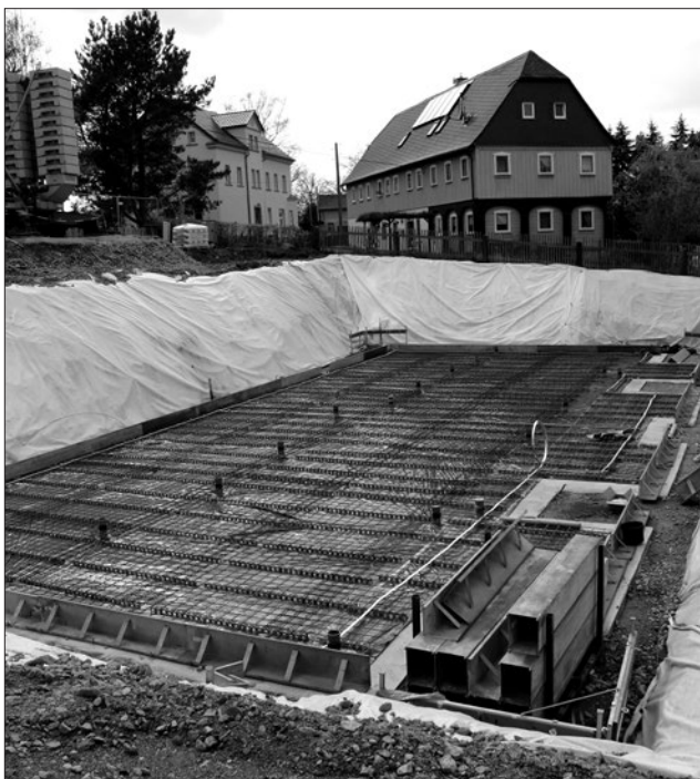
Die Vorbereitungen für die Herstellung der Bodenplatte sind nahezu abgeschlossen, aktuell dürfte der Beton bereits eingeschüttet worden sein.
