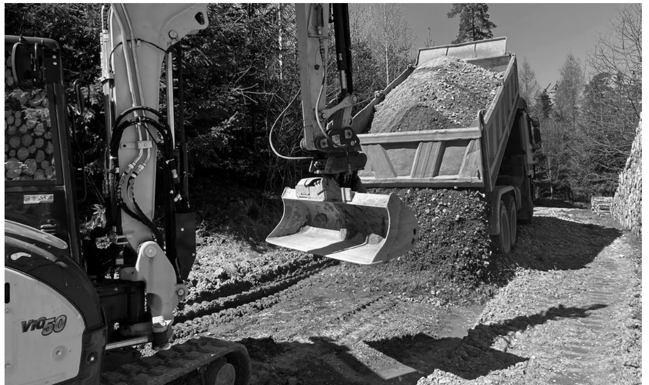
Bis zu 25 solcher Muldenkipper mit recycelten Betonmassen wurden pro Tag auf den Bierweg transportiert. Von der Waldkante bergauf ist der Forstweg nun nachhaltig befestigt worden.
