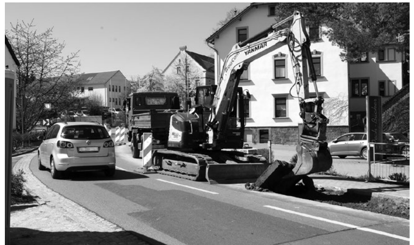
Bis Pfingsten sollen die Bauarbeiten auf der Oberlausitzer Straße fertig sein.
