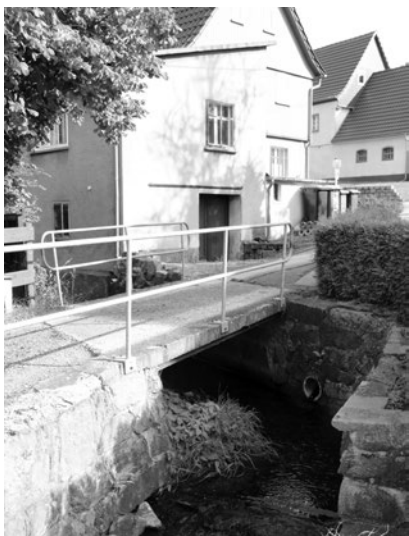
Noch im Herbst könnten die Arbeiten an dieser Brücke in Obercunewalde beginnen.
