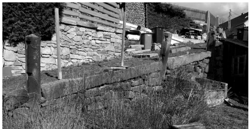
Diese rückwärtige Stützmauer (vorn im Bild) an der Hauptstraße 157 wird in Kürze saniert.
