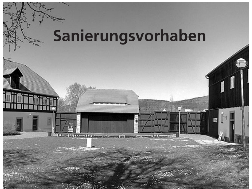
Mit der Ausschreibung der Bauleistungen zur Erneuerung der Toranlagen haben die Maßnahmen zur Sanierung im Dreiseitenhof ihren Anfang genommen.
