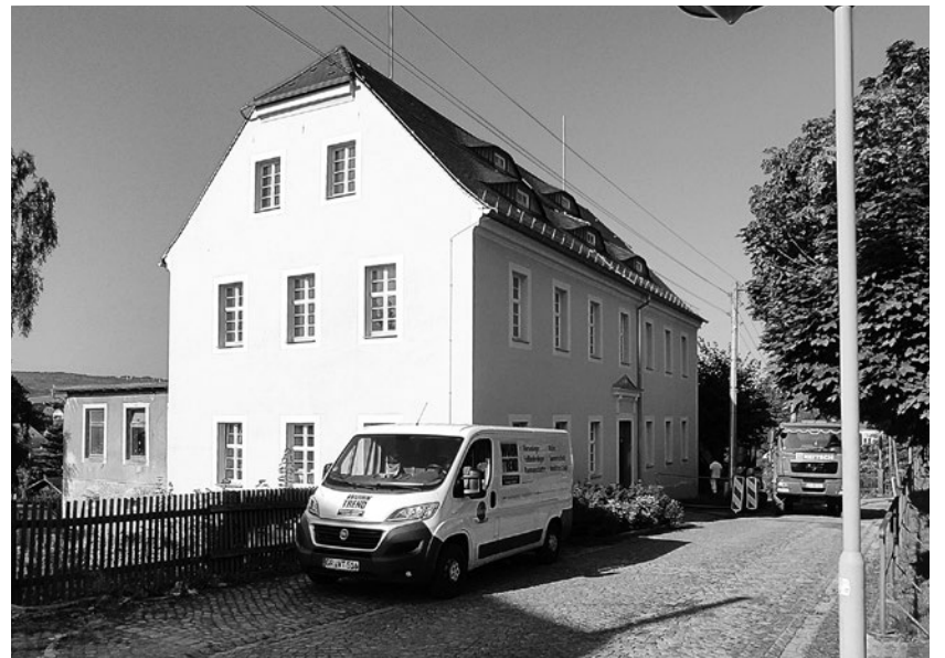
Im Außenbereich der Kirchschule sind noch Arbeiten im Gange, innen ist alles wie geplant realisiert worden.
