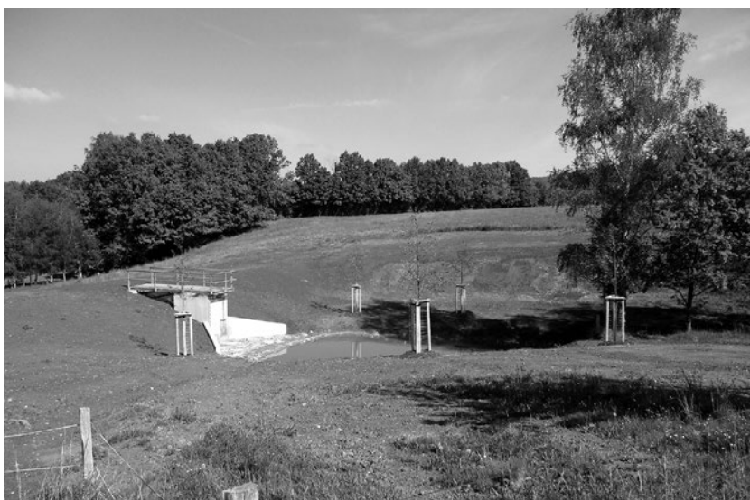
Der Staudamm im „Schwarzen Winkel“ ist fertig und bereits abgenommen.
