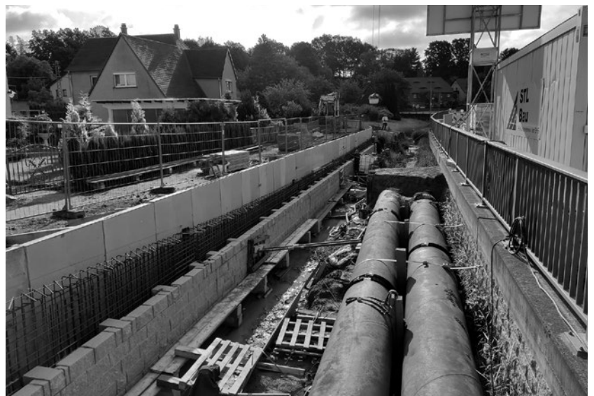
Die neue Stützmauer am Erlenweg nimmt bereits sichtbar Gestalt an.
