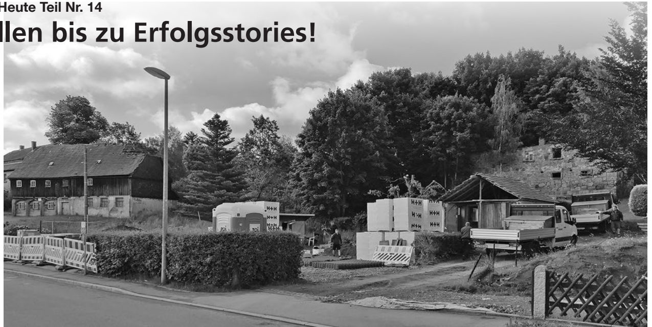
Zwischen den beiden Brachen Hauptstraße 110 und 114 entsteht auf dem Grundstück Hauptstraße 112 ein neues Wohnhaus. Gibt es für die verfallenden Häuser auch bald eine Lösung?
