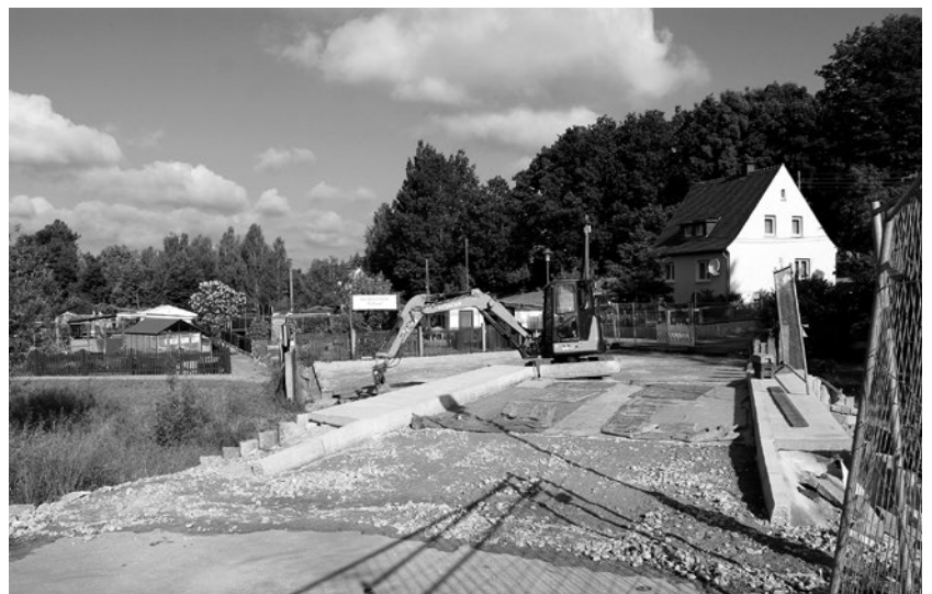
Die Sanierung der Brücke zum Nordhang geht ihrer Vollendung entgegen.
