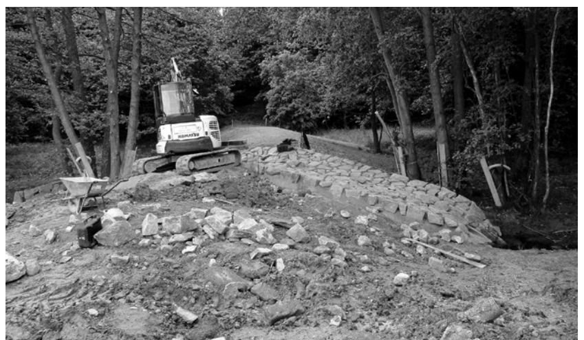
In der Wolfsschlucht sind letzte Arbeiten am Dammbau vollzogen worden.
