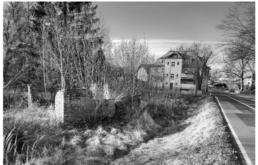
Die Reste des Häuschens Hauptstraße 262 werden spätestens im Frühjahr 2023 beseitigt.
