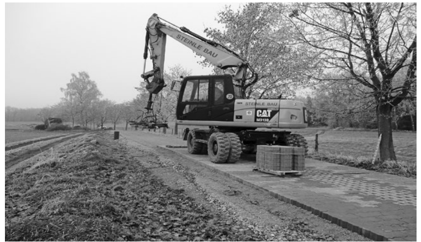
Bis eine Woche vor Weihnachten sollen die Pflasterverlegearbeiten auf dem Bierweg abgeschlossen sein. Restleistungen werden im Januar 2023 erledigt.
