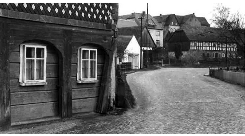
Die „Scharfe Ecke“ ist wirklich eine scharfe Ecke! Hier hat ein LKW einen Teil des Eckstützbalkens heraus gebrochen.
