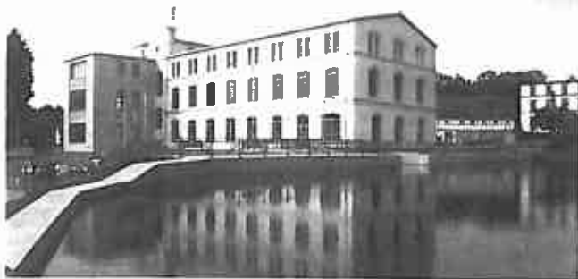
Das Gemeinde- und Bürgerzentrum vor und nach der Erneuerung
