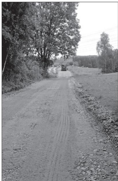
Der Bierweg. Aktuell wird der Unterbau für die geplante Pflasterung eingebracht.
