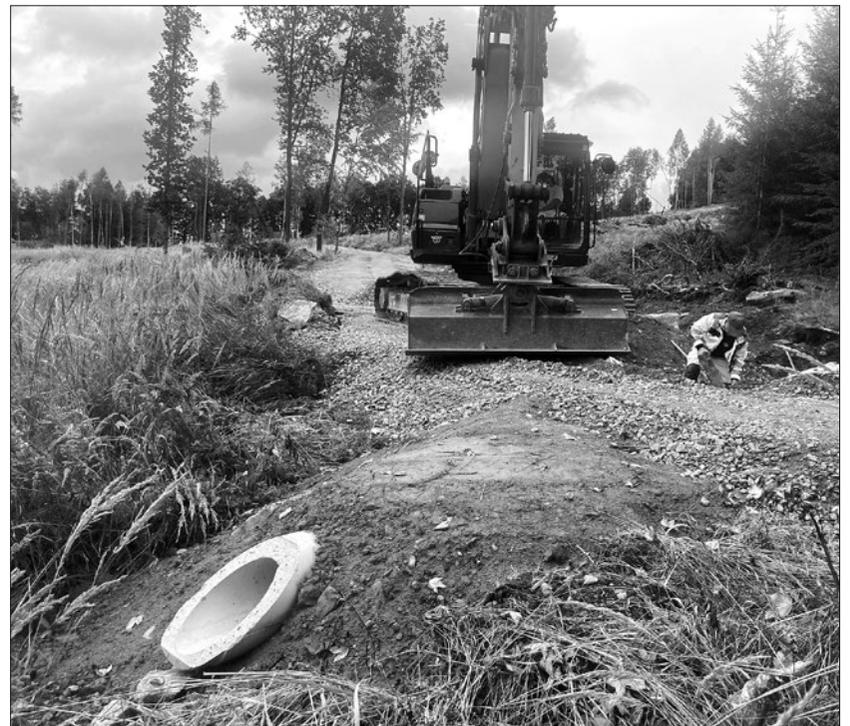
Mit großer Intensität sind die Wegebauarbeiten im Waldstück des Bierweges vorangetrieben worden. Mehrere Durchlässe wurden für den Abfluss von Oberflächenwasser eingebaut.
