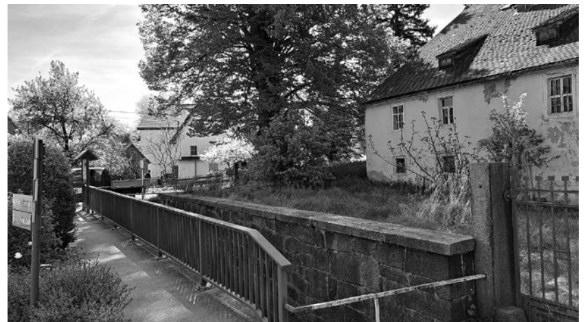
An der Ölmühle nahe der Bushaltestelle „Bielebohrstraße“ in Obercunewalde wird gebaut. Es ist nur mit minimalen Verkehrseinschränkungen zu rechnen.
