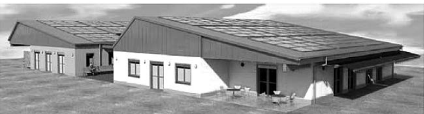
Ansicht Süd - West mit Sheddach u. PV-Anlage
