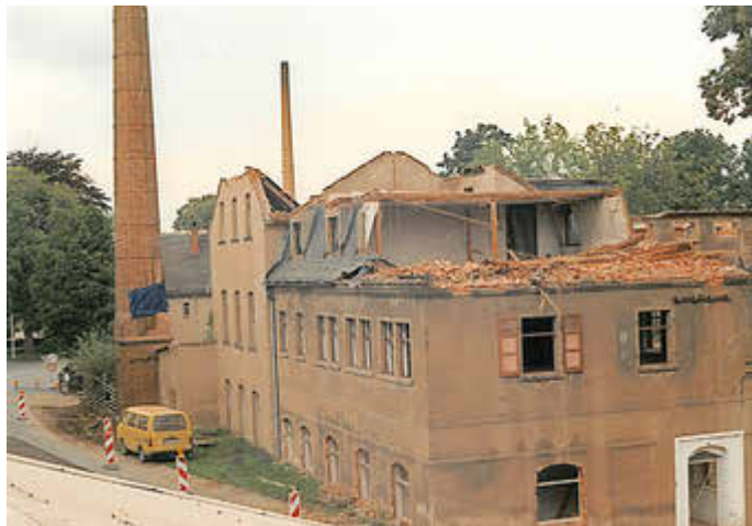
Blick auf die Altsubstanz der Carl Kalauch Textilbetriebe. Im August 1993 begann die Beseitigung. Heute befinden sich hier der Parkplatz und die Außenanlagen des Hotels.
