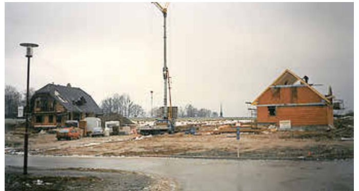
Dezember 1997 - die ersten beiden Häuser am Eichenweg sind rohbaufertig, im Mai 1998 konnten die Familien in ihre Neubauten einziehen.
