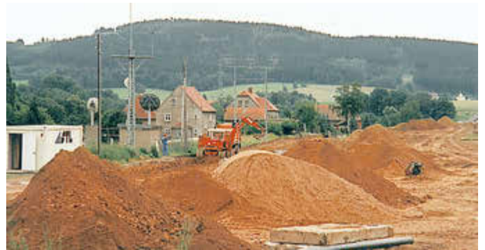
Erste Baumaßnahme am Wohnungsbaustandort Siedlungsweg war der grundsätzliche Ausbau der Anliegerstraße einschließlich begleitendem Gehweg. Die Arbeiten begannen im April 1997.
