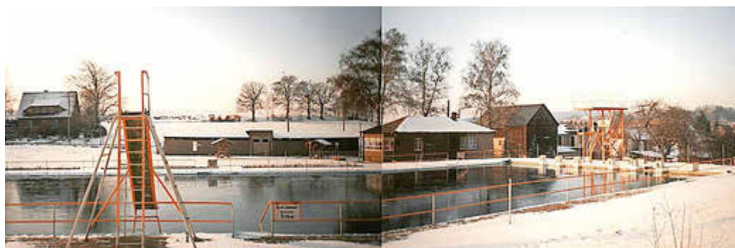
Januar 1994. Im Cunewalder Volksbad herrscht Winterruhe, die bald endet, weil die Bagger für den Totalumbau schon bereit stehen.
