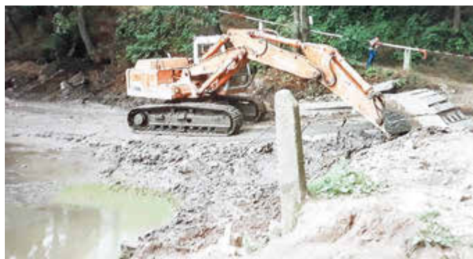
1998 - hier wird geschlämmt, ebenfalls Weigsdorfer Teich
