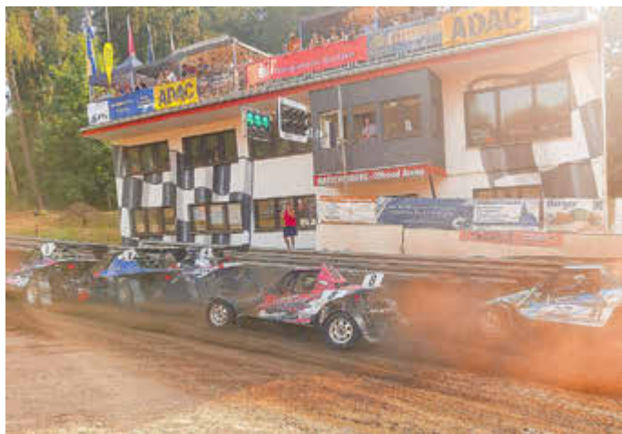
Das sanierte Start- und Zielgebäude bestand seinen Hätetest! Foto: T. Hohlfeld
