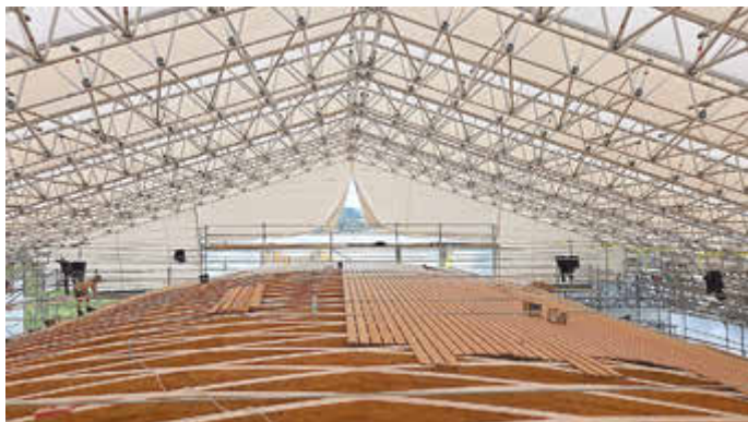
Auf dem Dach der Turnhalle mit Blick auf den Teil des Daches, welches ersetzt werden musste. Foto: A. Bierke
