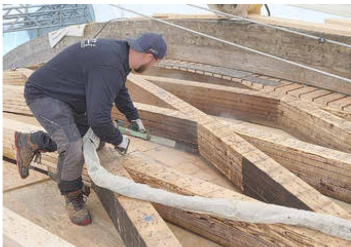
So sieht das Strahlen mit Trockeneis aus - die Ergebnisse sind klar erkennbar.
