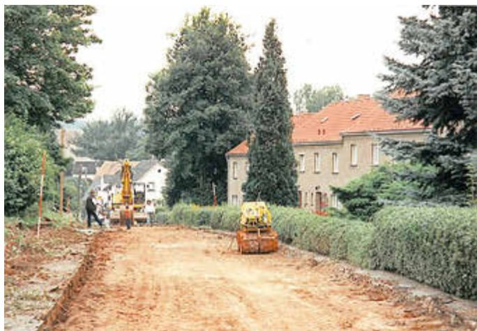
Die Straße Friedensau – Klipphausen wurde im Jahre 1996/97 grundhaft ausgebaut, für viele ein deutliches Zeichen, dass es im Straßenbau vorangeht. Foto: Ortschronik
