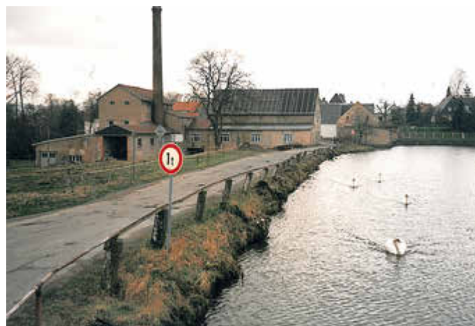
Die Straßen in der Neuen Sorge. Wie hier auf Höhe Teichmühlteich bestand überall dringender Sanierungs- und Ausbaubedarf.
