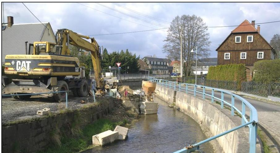
**Abbildung 18** Beispiel Uferinstandsetzung am Erlenweg
